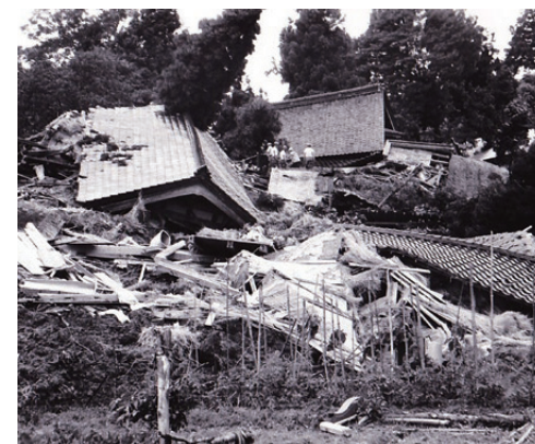
昭和39年7月富山県胡桃地すべり被害状況写真
