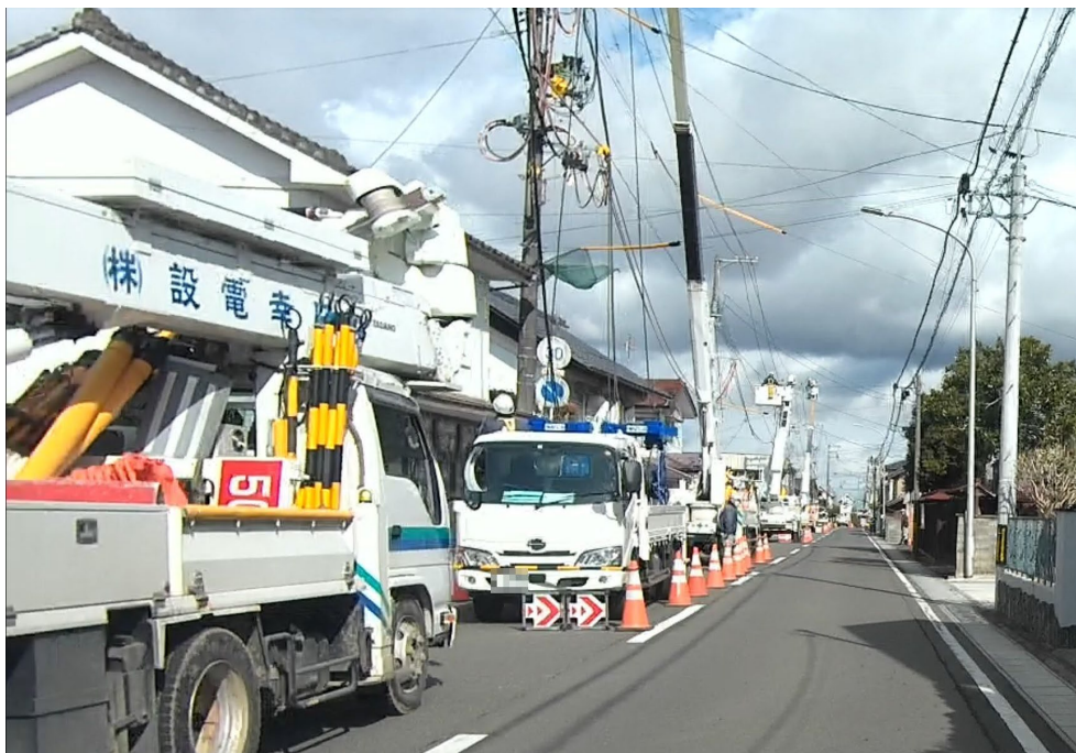
巨理町の停電電線復旧工事
