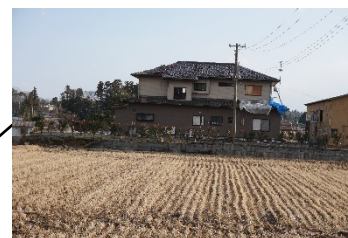
210216_新地町家屋被害
