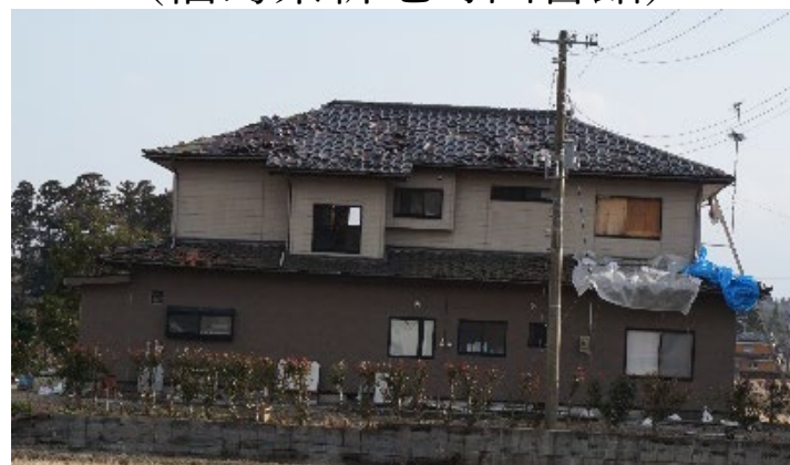
建物被害（福島県新地町）
