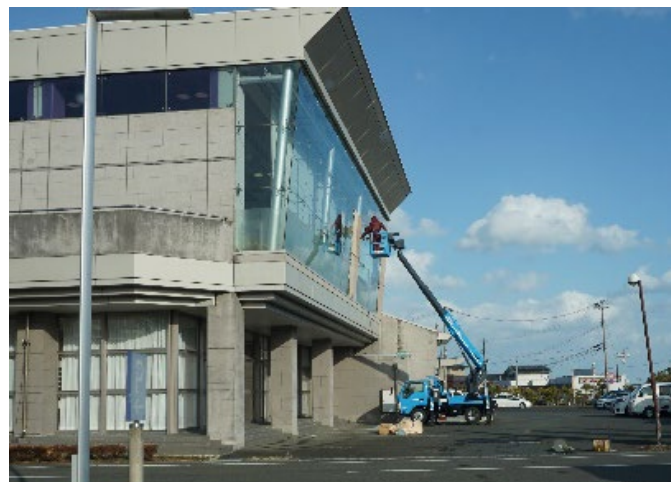
建物ガラス被害修理中 （福島県新地町図書館）
