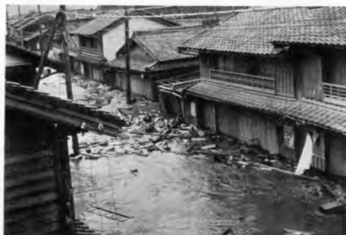
写真13 尾鷲湾引本における満潮状況
