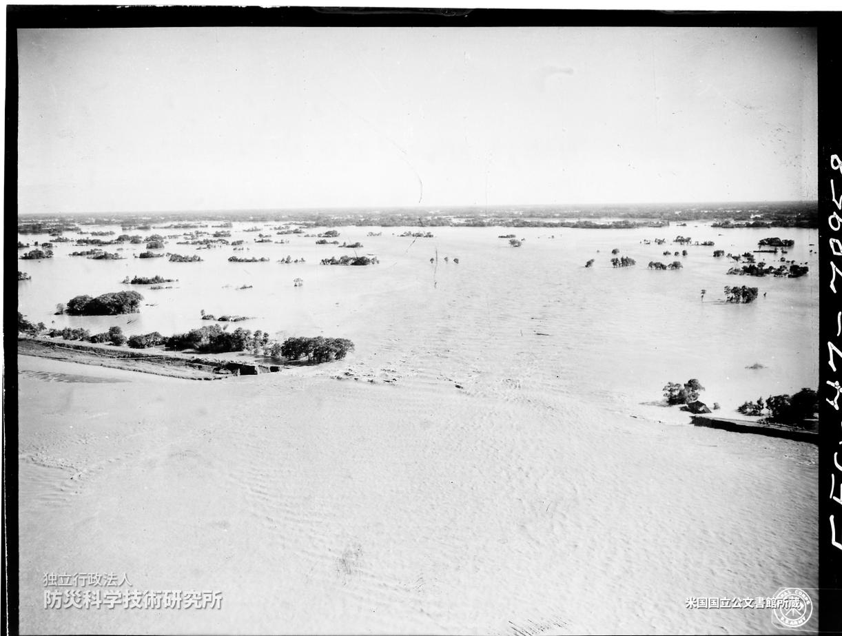
利根川新川通りの破堤口から平野部に向かって溢れ出る利根川の濁流。破堤口は約400m。浸水域に浮かんで見える島状の部分は自然堤防。
