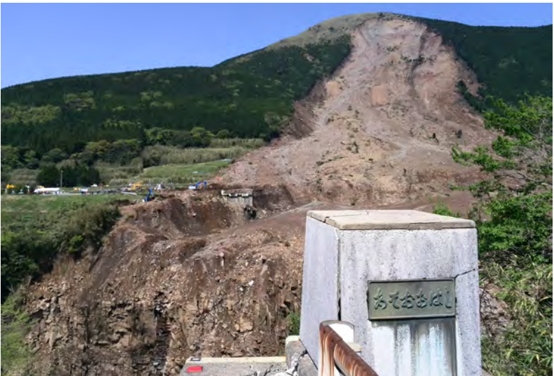
平成28年熊本地震 熊本県南阿蘇村立野の崩壊 (2016年4月30日)
