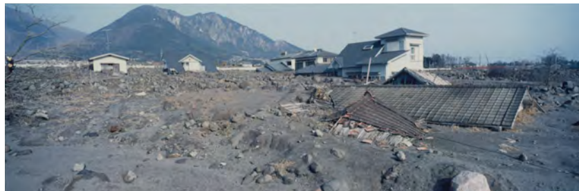
平成3年雲仙岳噴火 土石流によって厚い土砂で覆われた水無川下流の住宅地
