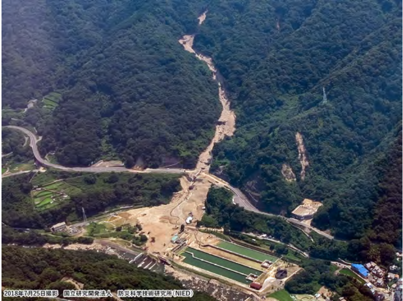
平成30年7月豪雨 広島県呉市広町二級水源地の土石流 (2018年7月25日)
