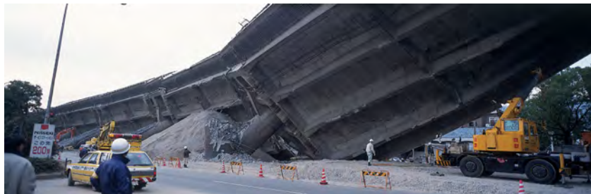
阪神・淡路大震災 倒壊した阪神高速道路の高架
