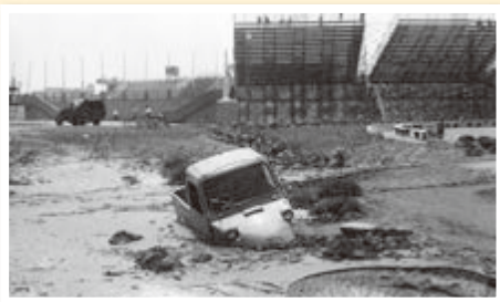
1964年新潟地震における液状化被害
