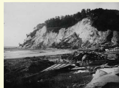
▲1923 年関東大震災後の斜面崩壊と津波被災後の様子
