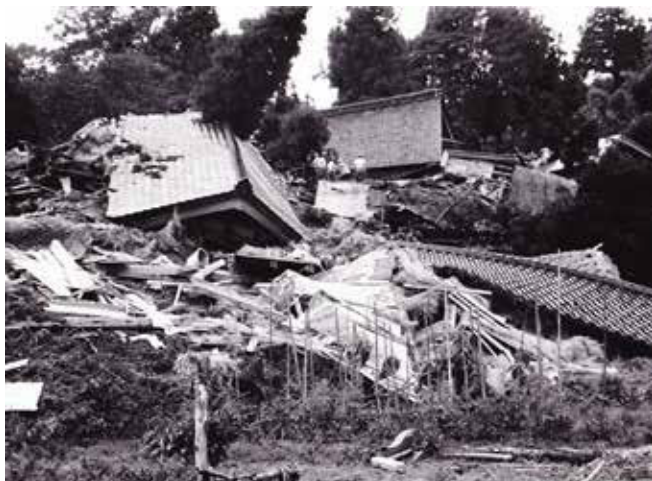
昭和39年7月富山県胡桃地すべり被害状況写真
